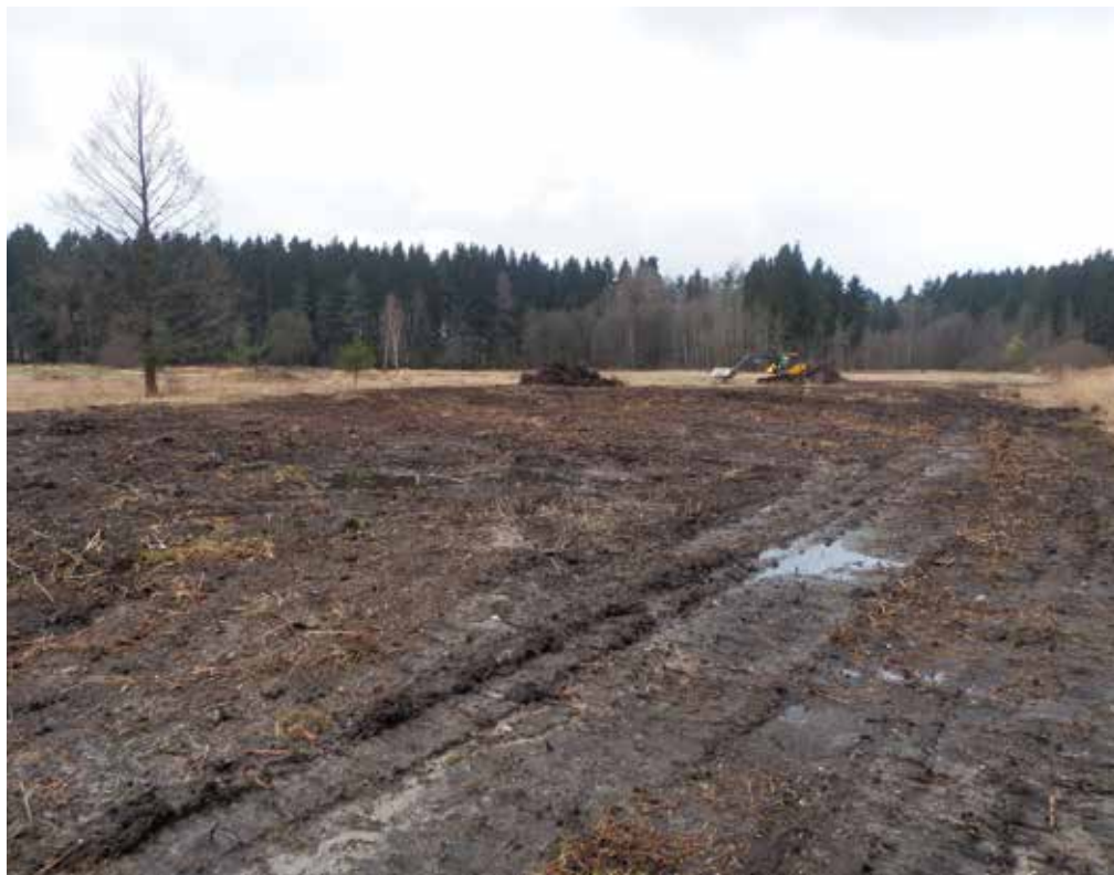
Obr. 47: Ukázka kompletního stržení drnu na plochách porostlých silně degradovanou až ruderální vegetací v PR Chvojnov. Zásah byl proveden v rámci revitalizace rašeliniště na plochách silně degradovaných odvodněním a absencí pravidelné seče v sousedství zachovalé části rašeliniště. Foto: V. Kodet.
